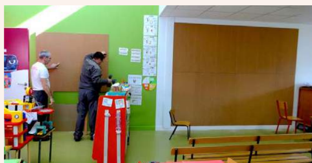
Pose de panneaux d'affichage en liège à l'école Duclos-Lanoy
