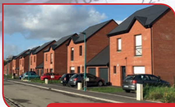
Nouvelles constructions à la Berce gayant
