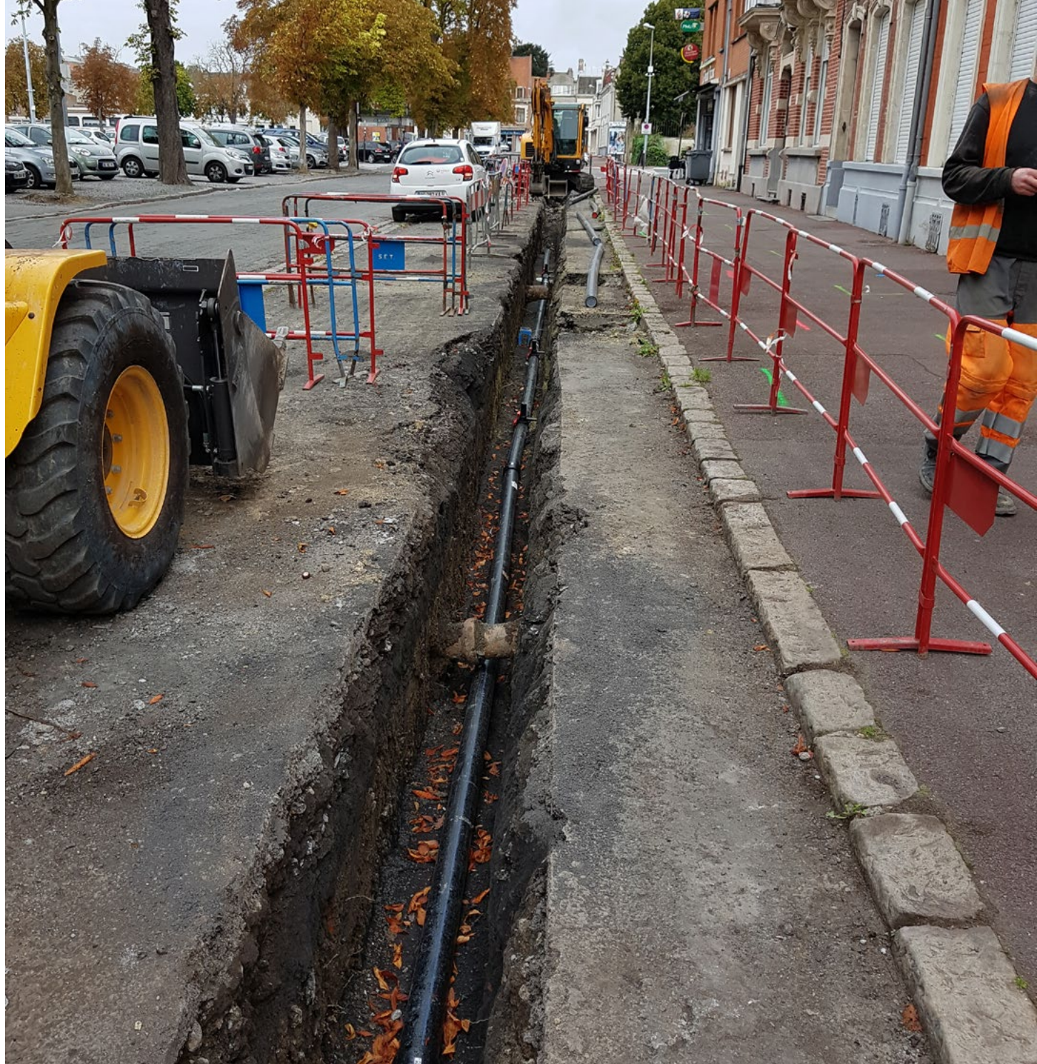
Pose d'une canalisation à Douai.
